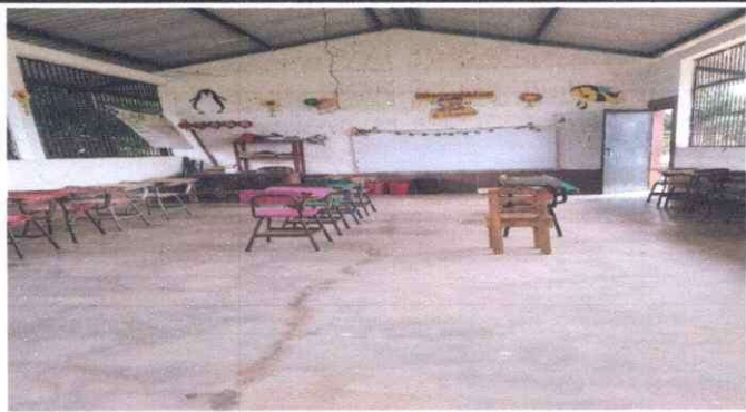
Foto1: Sustitucion de piso a ceramica del aula.
